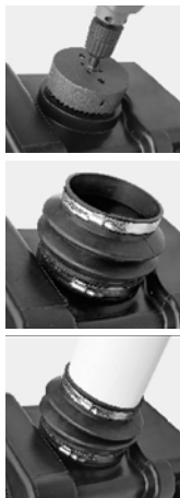
Рис. 8 Подсоединение вертикального подводящего трубопровода 110 мм (DN100)
